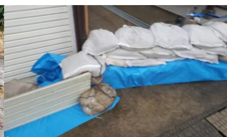
土嚢による浸水対策
