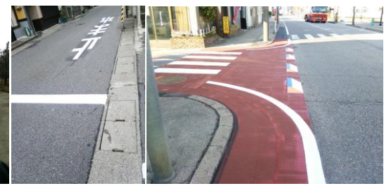
通学路安全対策・道路整備
