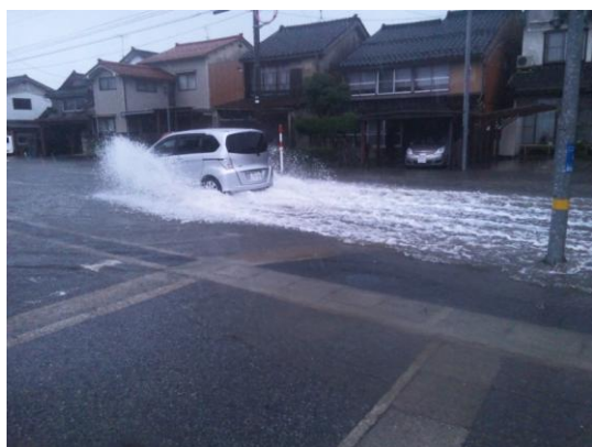
6月の道路冠水の状況。
