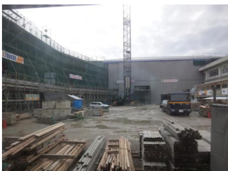
3月まで建設が進む山王小学校校舎 行政への要望により、屋上の津波避難 可能人数が 1000人→1500人に拡大
