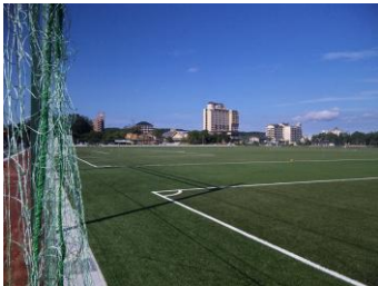
サッカー合宿拠点施設「和倉温泉多目的グラウンド」
