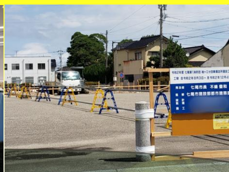
消防分団施設建設
